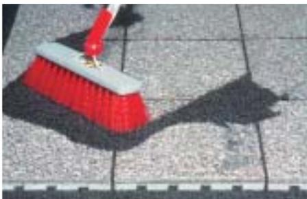
Bei ebenem Untergrund wird LEYCOMAR einfach direkt lose auf den ebenen Untergrund verlegt.
