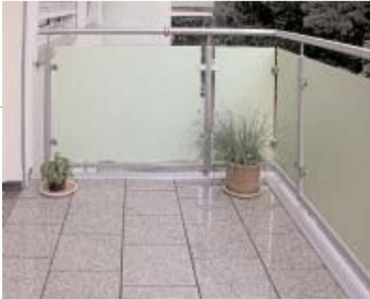
Die LEYCOMAR-Platten werden nicht verklebt und können somit weder durch Frost noch durch die Bildung von Wasserdampf beschädigt werden. Das drainagefähige Fugenmaterial ermöglicht eine Ausdehnung der Eiskristalle in den Hohlräumen und ein Entweichen des Wasserdampfes.
